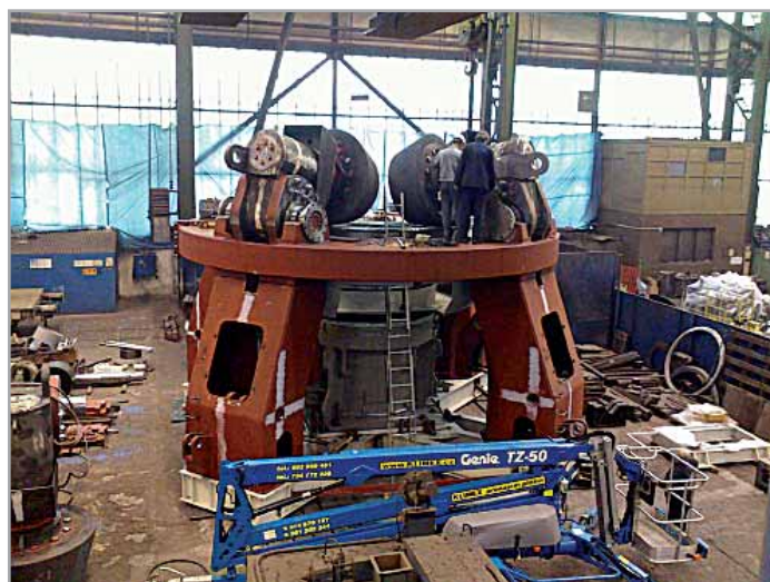
Установка маятников бегунов в подшипники
