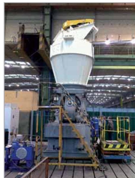
Реконструкция мельницы КТМ 1200 в цеху «PSP»
