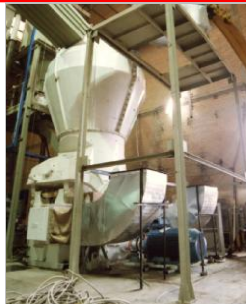
Montáž mlýna KTM 1600 pro mletí suroviny pro výrobu dlažby a obkladů.
