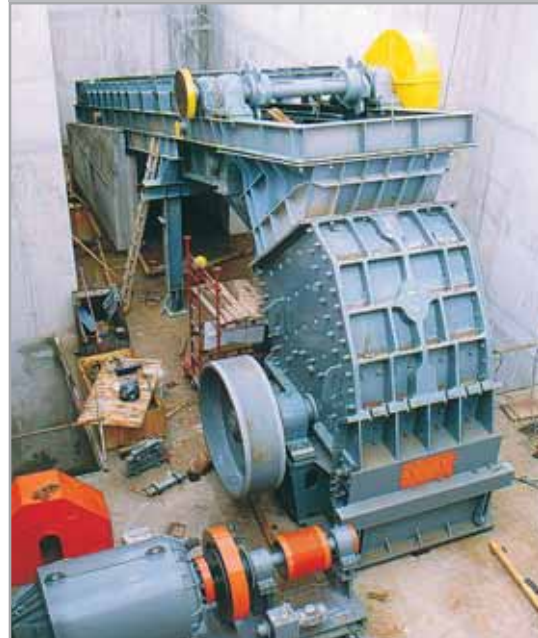
Montáž článekového podavače CPLDT 1600x12000
