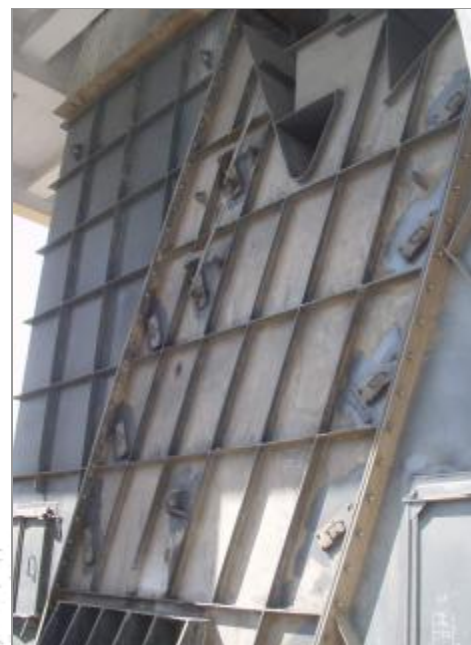
Pohled na horní část třídiče se vstupem materiálu a výstupem plynu
