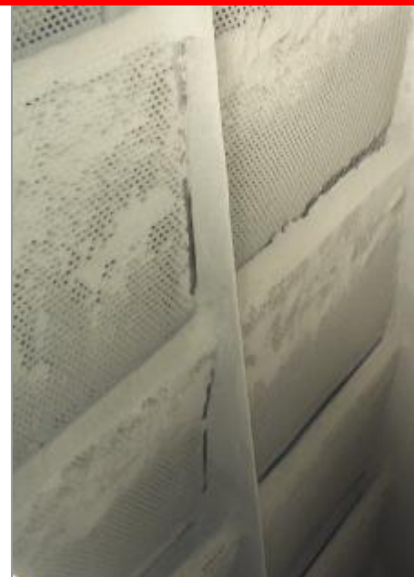
Pohled na přepážky
