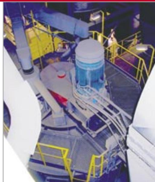
Воздушный сепаратор VTP 2700 в цехе помола цемента 80 тн/час – цементный завод CEMMAC Horúe Smie, Словакия
