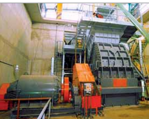
Drtič OKD 2020 drcení vápence 450t/h
