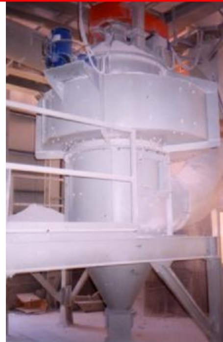
Vzduchový třídič VTP 1100 v mlýnici vápence 9 t/h – Redipuglia, Itálie
