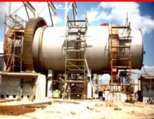
Montáž mlýna pro mletí suroviny Ø 5,4x11 m se sušicí komorou.
